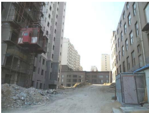
锅炉房南侧路及南侧住宅楼
