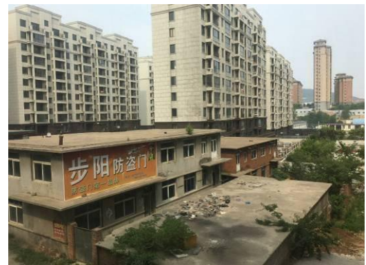
锅炉房东侧居民楼
