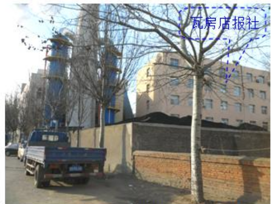
近看锅炉房烟囱及脱硫塔
