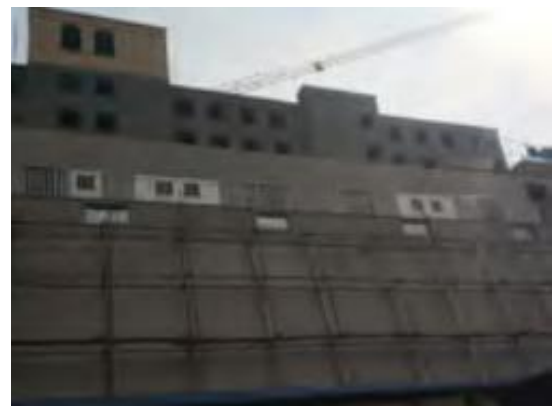
锅炉房南侧的在建的老年公寓
