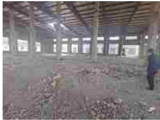
西南侧厂房内部
