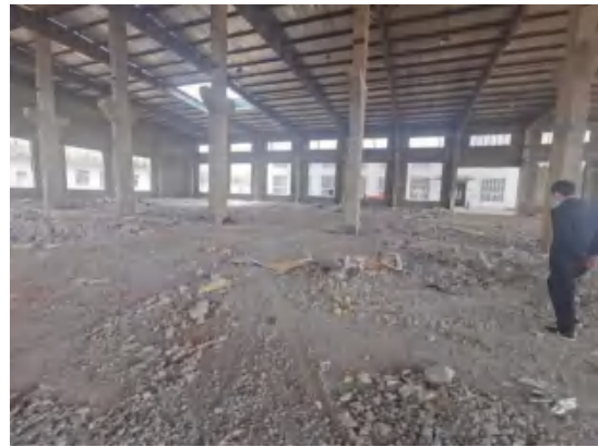
西南侧厂房内部
