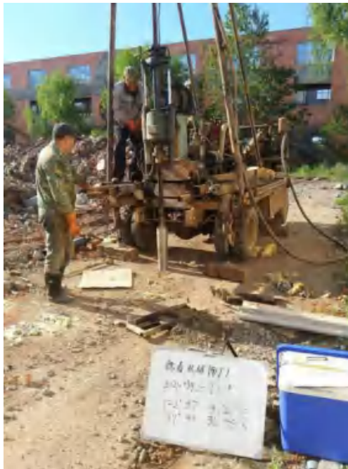
图 8.2 钻探车采样照片
