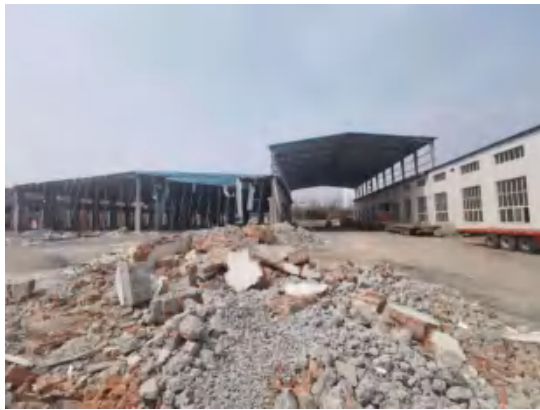
西南侧厂房外部
