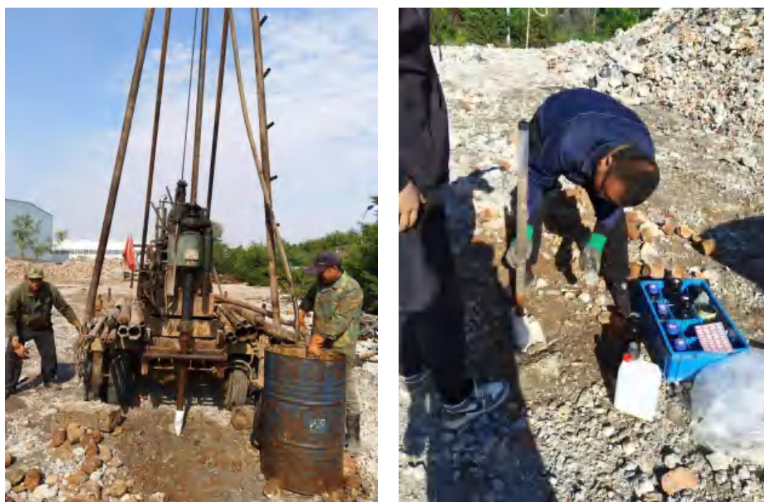
图 8.3 建井、采样照片
