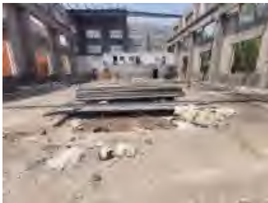
日盛公司-厂房内部
