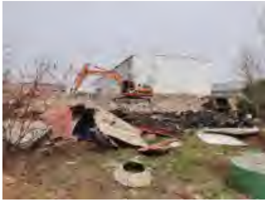
日盛公司-已拆除厂房位置
