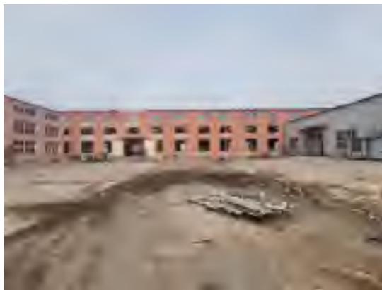
日盛公司-厂房外部
