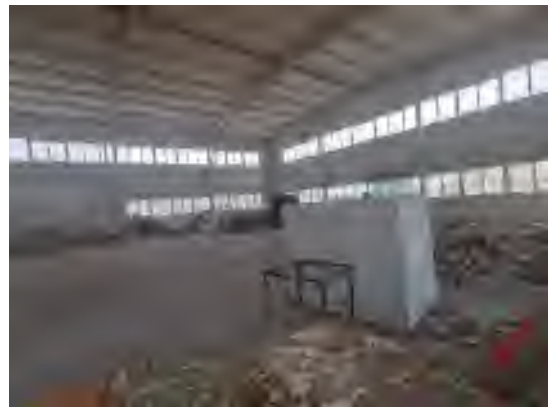
丰华公司-厂房内部
