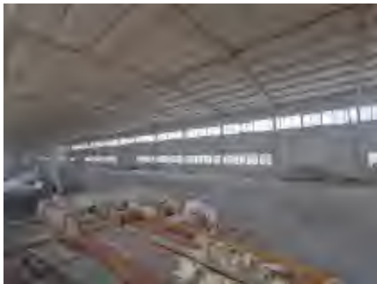
丰华公司-厂房内部
