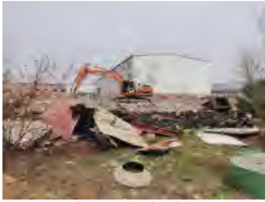
日盛公司-已拆除厂房位置
