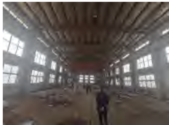
日盛公司-厂房内部
