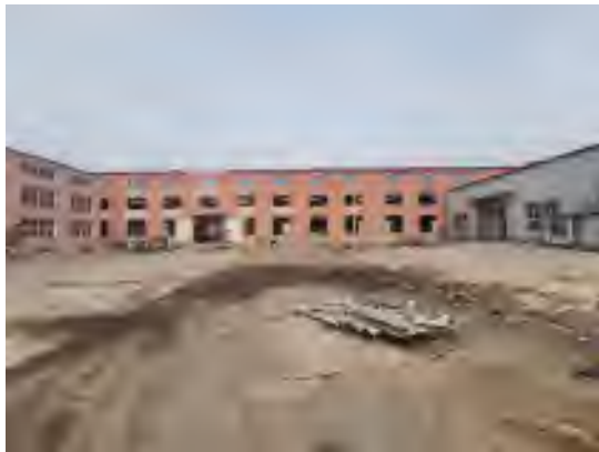
日盛公司-厂房外部
