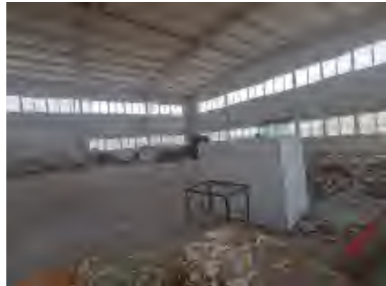
丰华公司-厂房内部
