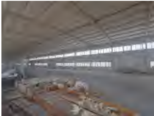
丰华公司-厂房内部
