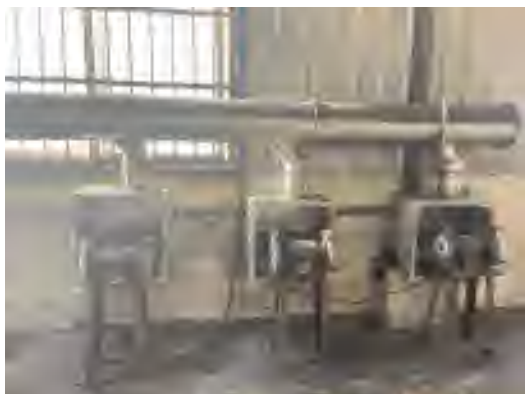
图 16 打磨机及集气罩
