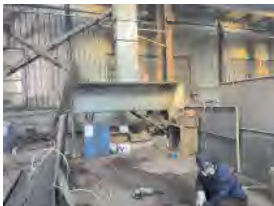
图 18 焊接区域集气罩
