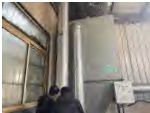
图 17 袋式除尘器及排气筒
