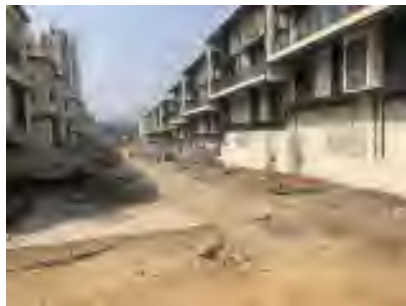
项目地块内南侧
