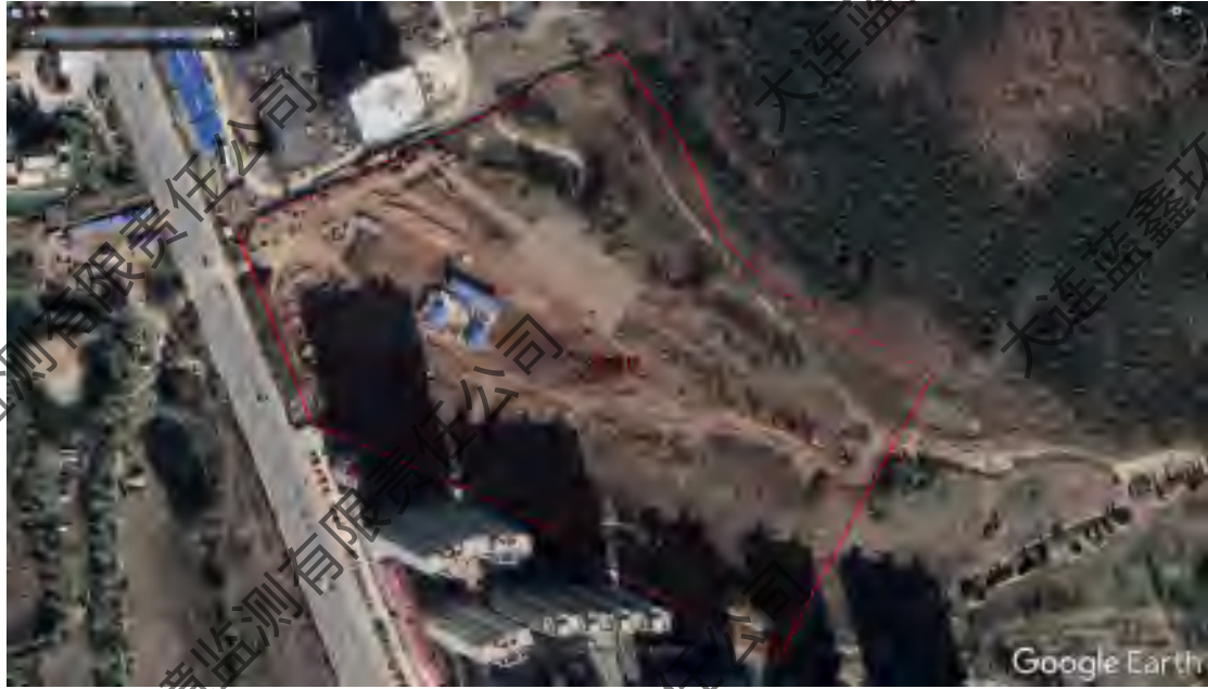
2021年11月，本项目地块出售做居住用地开发，地块内部分土地平整，原有板房拆除，建设新的活动施工板房
