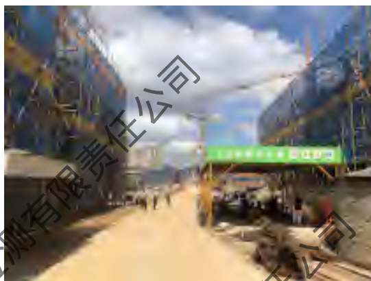
地块内部分建设、地块内小路
