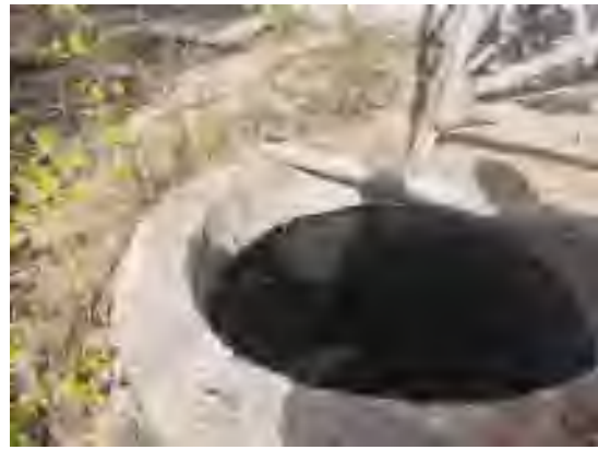
循环冷却水井
