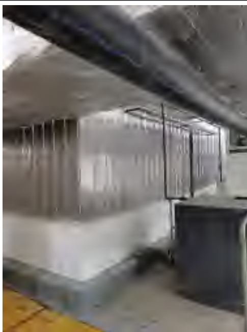
图 2.2 恶臭气体处理生物过滤装置及其 15 米高排气筒
