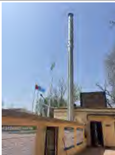
图 2.2 恶臭气体处理生物过滤装置及其 15 米高排气筒
